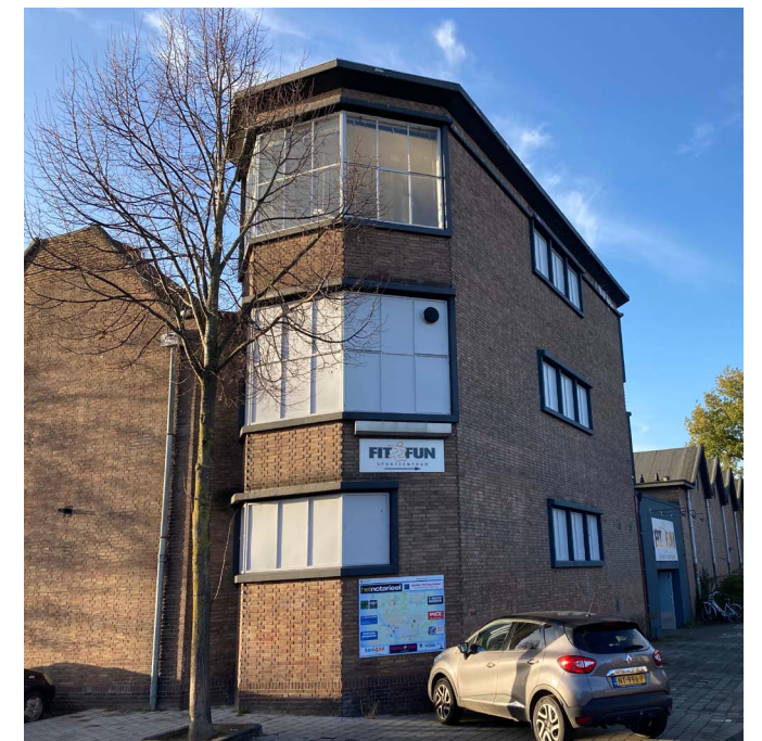
Kantoorgebouwtje aan de Tapijtsstraat van Postma
