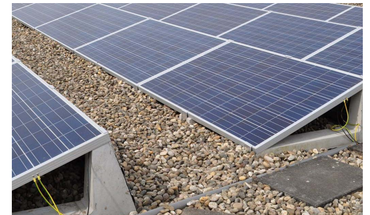
4. Hoogste daken met dakgrind en zonnepanelen
