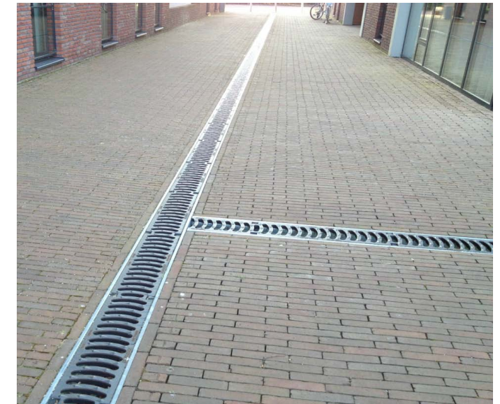
Centrale roostergoot in de buitenruimte
